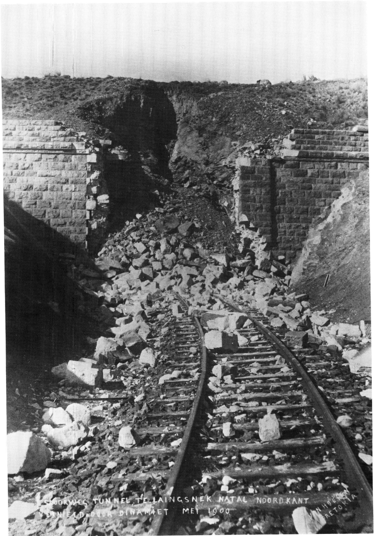
Spoorwegtunnel te Laingsnek Natal. Noordekant verniel deur dinamiet Mei 1900.
