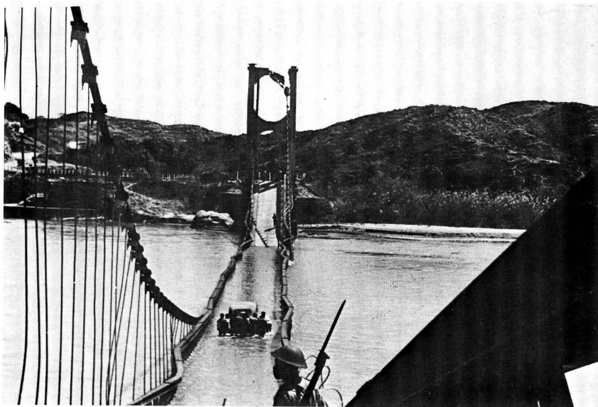
Die Betsiebokabrug — nog bruikbaar na die sabotasie.
